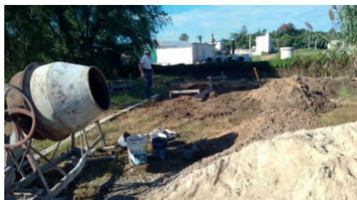
Obras de la construcción del centro San Mateo, en Argentina.
